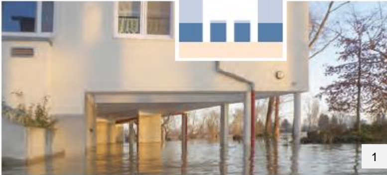
Ausweichen: zum Beispiel durch Aufständern von Gebäuden
