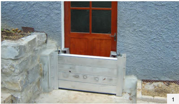
Objektschutz an Gebäudeöffnungen
