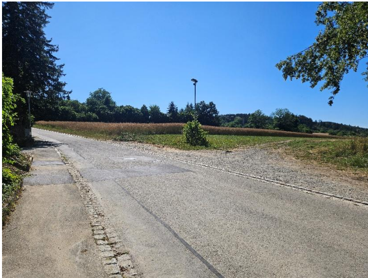
Blick von Süden auf den Hohreuteweg und das Plangebiet
