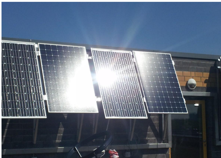
Abbildung 8: Veranschaulichung der Reflexion an einem texturierten Modulglas (mitte-links) und einem glatten Modulglas (mitte-rechts) - Quelle Aufnahme: Fraunhofer-Institut für Solare Energiesysteme ISE
