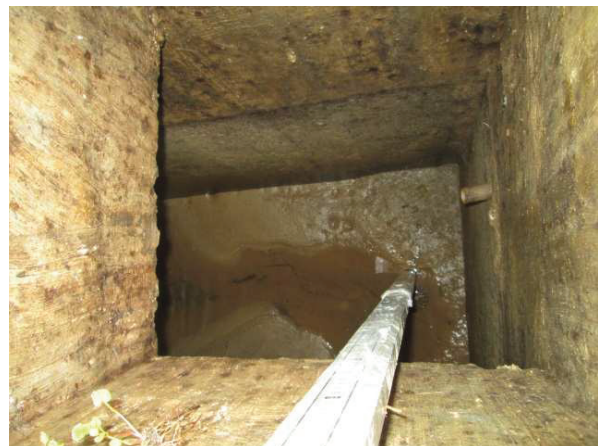
Abb. 3: Schachtsohle bzw. Gründungssohle
